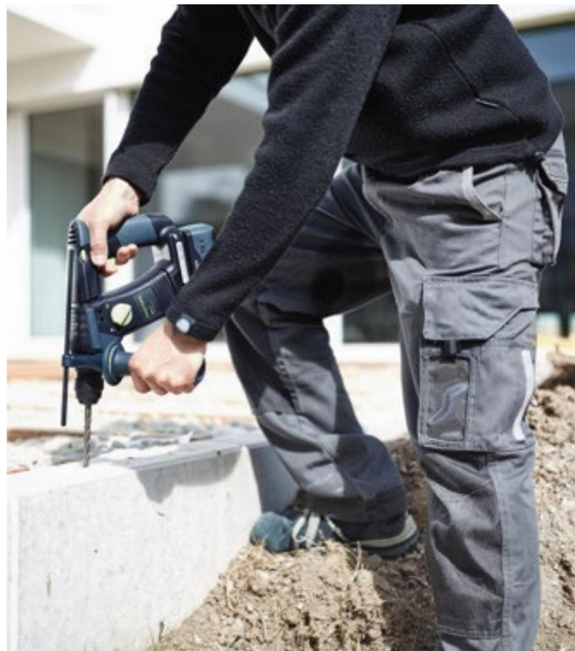
**ВНС 18** – надёжный и мощный инструмент для бетона. Его конёк: сверление с пневмоударом гнёзд под дюбели до 18 мм в бетоне, камне и кирпиче.
